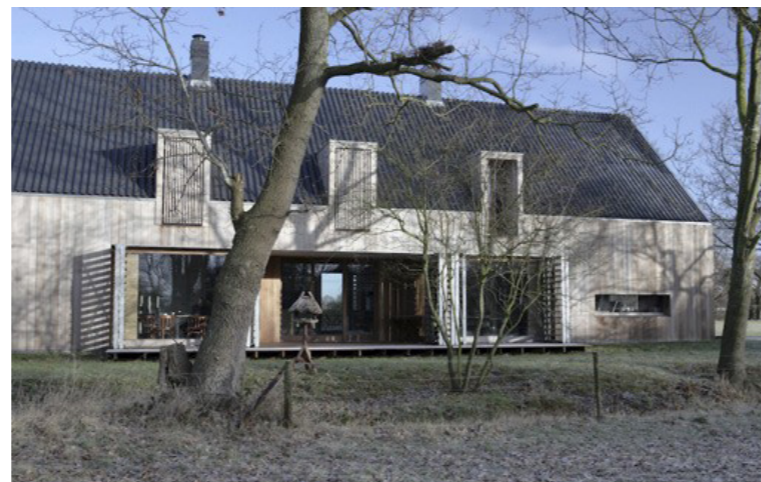
Dakkapellen als onderdeel van gevel ; onderschikt aan dakvorm ; smal en met voldoende afstand
