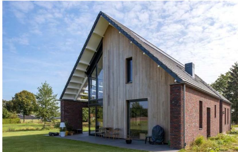
Hoofdwoning met metselwerk gevel
