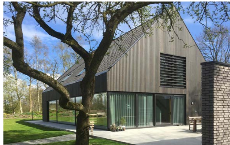
Overhoekse open gevel
