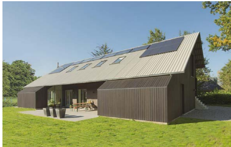
Schuurwoning met aanbouw
