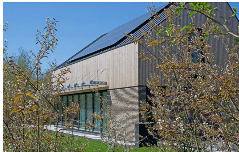
Gevel met verschillend materiaal in de gevel materiaal
