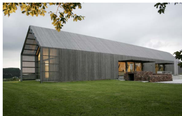
Schuurvorm met gevel en dak eenduidig materiaal
