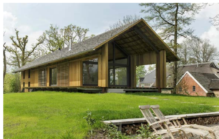
Schuurvorm met gevel en dak verschillend materiaal
