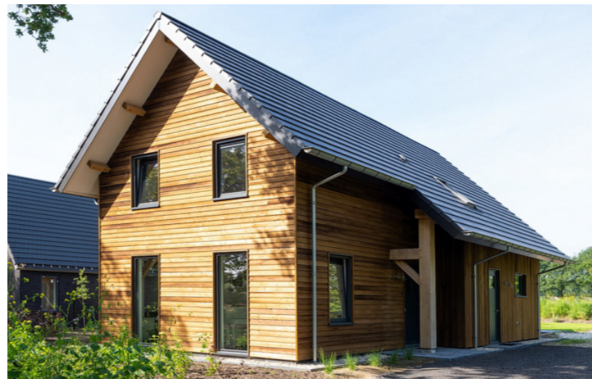
Hoofdwoning met gevel en dak verschillend materiaal
