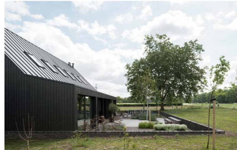
Dakgeknikte dakvorm aanbouw t.o.v. schuurvorm
